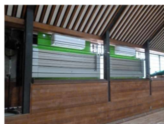
写真2 エアコンとパネル
