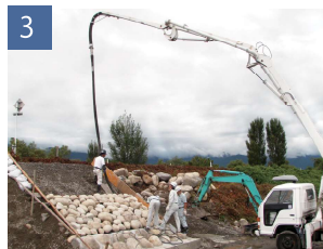
コンクリート打設
