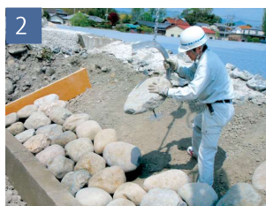
専用吊具使用・据付け状況
