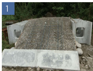
鉄筋架台設置完了
