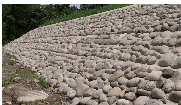
国土交通省 国道17号線綾戸第一橋梁（群馬県）
