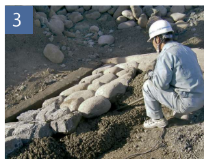
コンクリート打設(3列)
