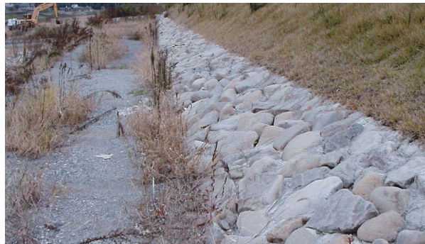
徳島県 通常砂防工事
