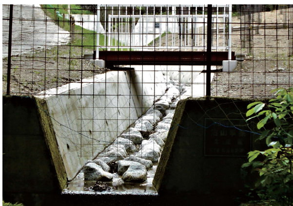
兵庫県 円山川 ストーンネットセービングタイプ
