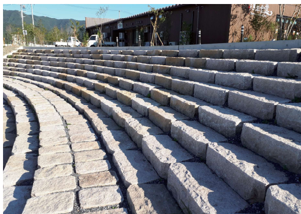
岩手県 須崎川 ストーンネット階段タイプ
