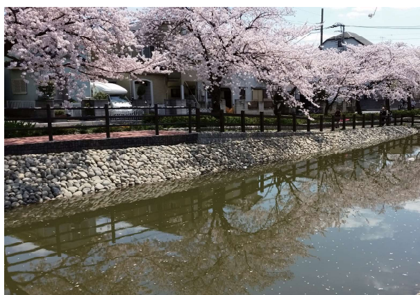
埼玉県 葛西用水路 ストーンネット樹脂メッシュタイプ
