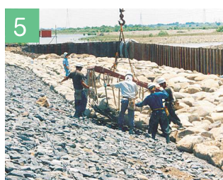
5 ストーンネット据付
