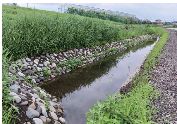
栃木県 赤城第3工区 ストーンネット標準タイプ
