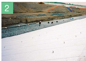
2 吸出し防止材敷設
