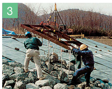
3 ストーンネット敷設
