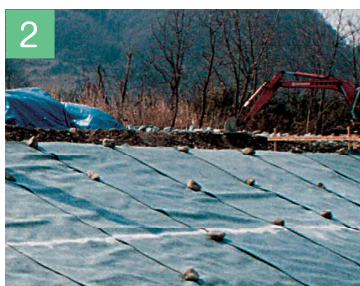
2 吸出し防止材敷設
