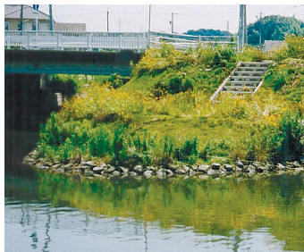
静岡県 一宮川 施工後1年半
