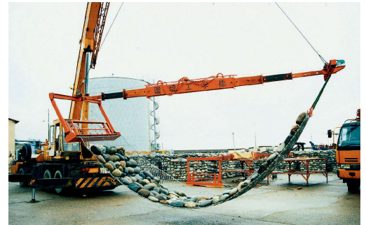
水中施工用吊り金具全景
