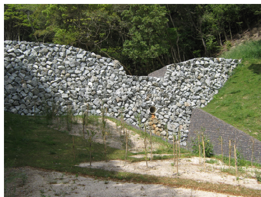
施工後 環境省 加太園地（和歌山県）
