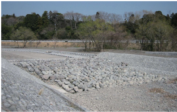
国土交通省 大井川 2t型 施工時
