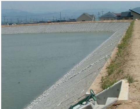
和歌山県 水栖大池
