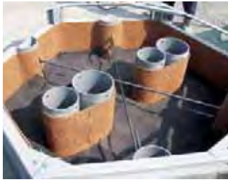
型枠組立完了
