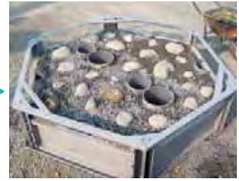
生コン打設完了
