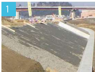
1 法面整形・基礎砕石転圧
