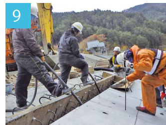
9 コンクリート締固め
