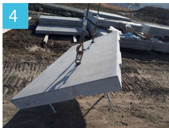
4 アンカー取付け後
