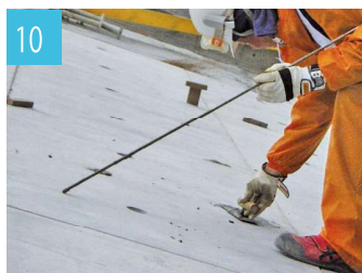
10 点検孔による充填状況確認 (ブロック1個当り3箇所)
