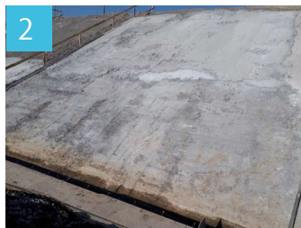
2 均しコンクリート打設
