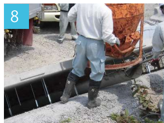
8 胴込コンクリート打設
