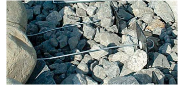
アンカー材とパネルの設置状況
