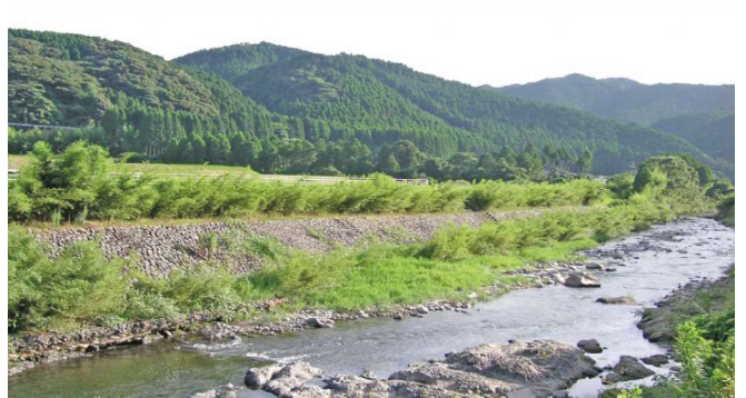
鹿児島県 米ノ津川 施工5年後
