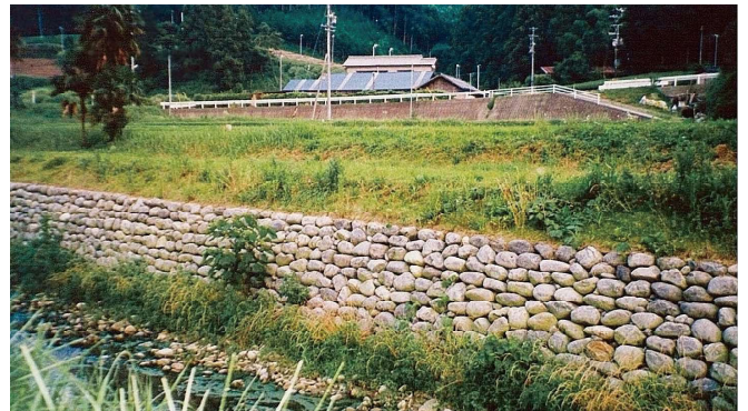
静岡県 沢水加川 施工3年後
