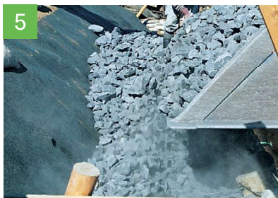
5 割栗石を投入して、均一にならします。(2～5を繰り返す) 割栗石は石の間隙から吸い出されないよう、粒径φ50～150mmを厳守ください。
