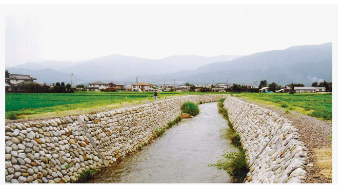
農水省 有明排水路(長野県) 施工1年後
