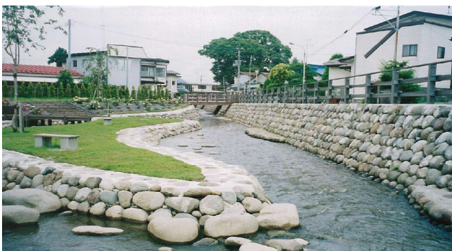
岩手県 大町川親水公園 施工2ヶ月後
