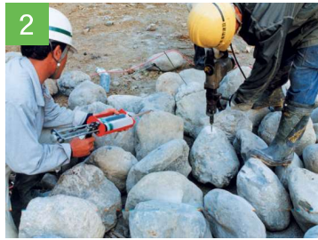
2 専用の注入ガンを使い特殊ボンドを孔に注入します。
