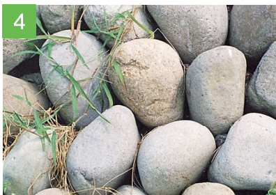
4 石は「かさね石」の状態にならないよう、適度な空隙を保持する「多孔積」に積上げます。
