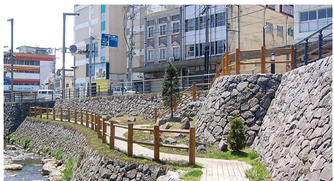
岩手県 大堰川 施工2年後
