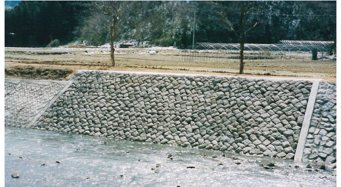
宮城県 斎川 現地材利用現場製作
