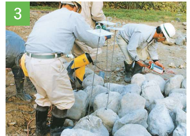
3 ストッパーパネルを通したアンカー材を孔に挿入し、1日養生します。
