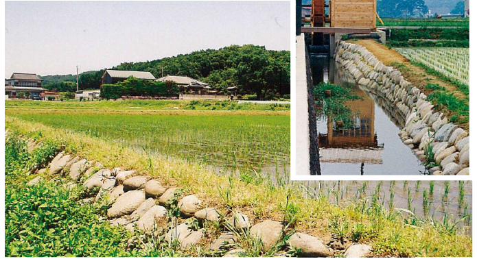
神奈川県 伊勢原市役所 排水路 施工4年後
