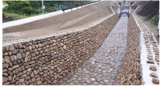
国土交通省 紀伊山系砂防事務所 那智川水系樋口川(和歌山県)
