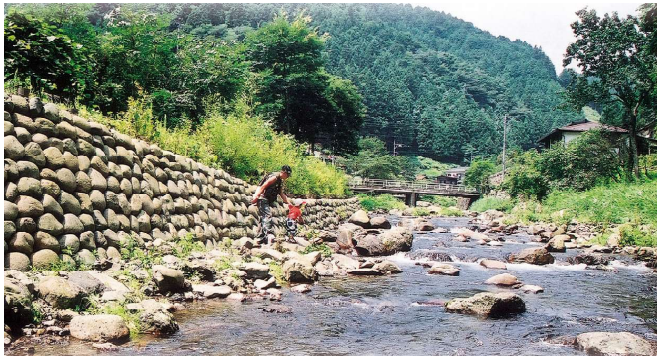
東京都 養沢川 施工3年後
