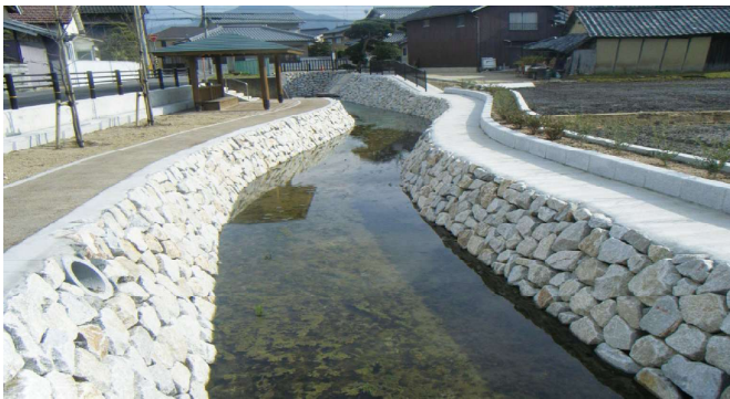
香川県 善通寺地区 農業水路 施工直後
