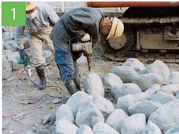
1 自然石を並べ、窄孔し、エアガン等で十分に清掃します。
