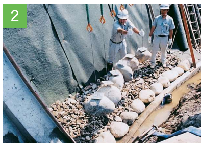
2 アンカー材の吊上げ部を利用して、クレーン等で仮置きします。
