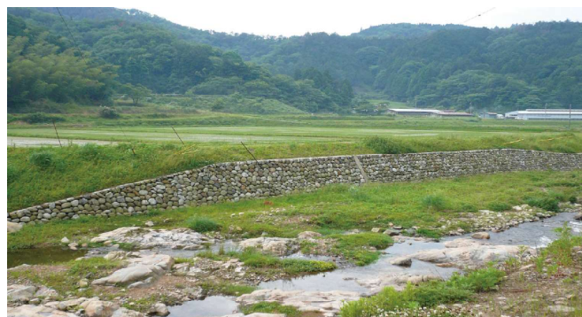
兵庫県 出石川 施工3年後
