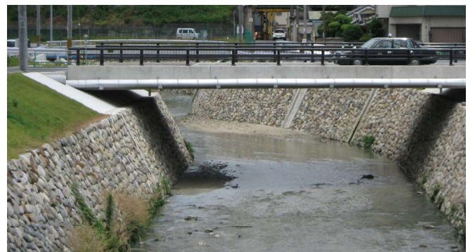
国土交通省 奈良国道事務所 R165号栄橋 葛下川(奈良県)
