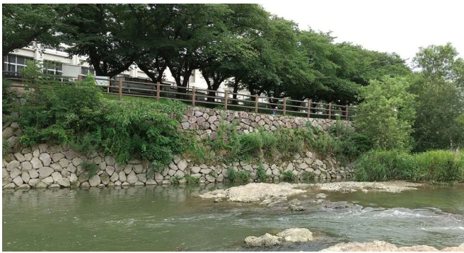
福岡県 那珂川 施工10年後
