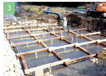
1層目設置完了
