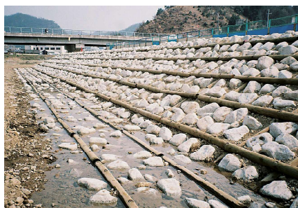
国交省 栗栖川 1層建型(ストーンネット併用タイプ)
