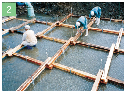
1層目設置・金具取付
