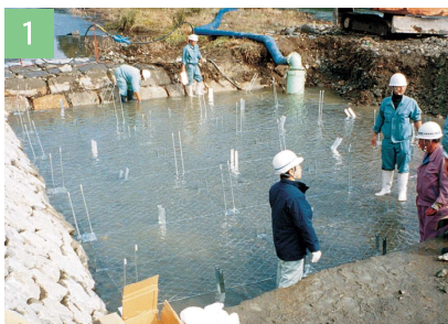
金網・連結金具設置
