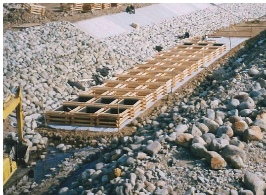
型枠組立・設置状況
