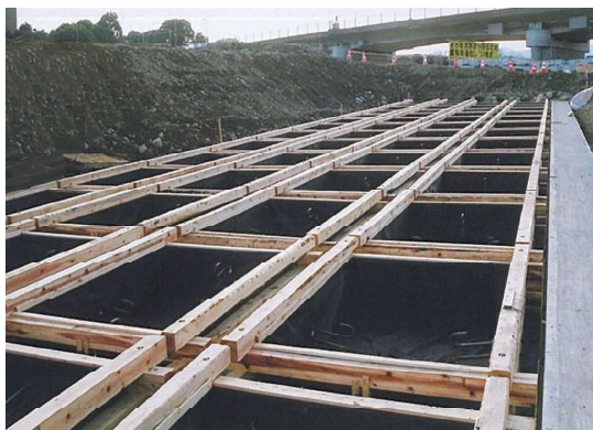
型枠組立・設置状況
