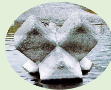
◀既存の護床ブロック
