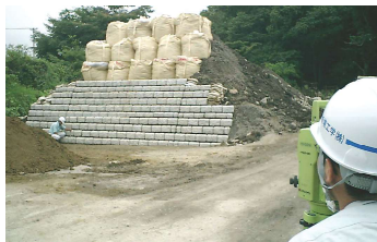
高盛土載荷試験(変位測定状況)
