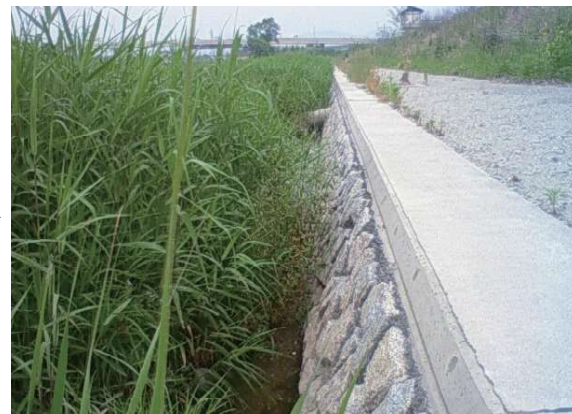
国土交通省 大和川上流浄化施設 (奈良県)
