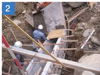
2 裏込材を投入し、締め固めます。
