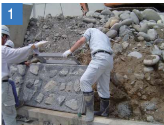
1 吊金具を使用し製品を据付けます。
