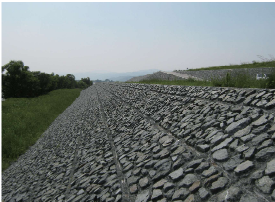
国土交通省 柿原漏水対策（徳島県）
