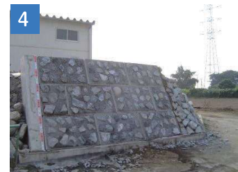
4 天端工を設置し完成です。
