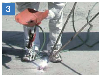
3 鉄筋下部を挿し筋に溶接して固定します。
