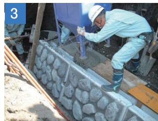
3 胴込コンクリートを打設します。
