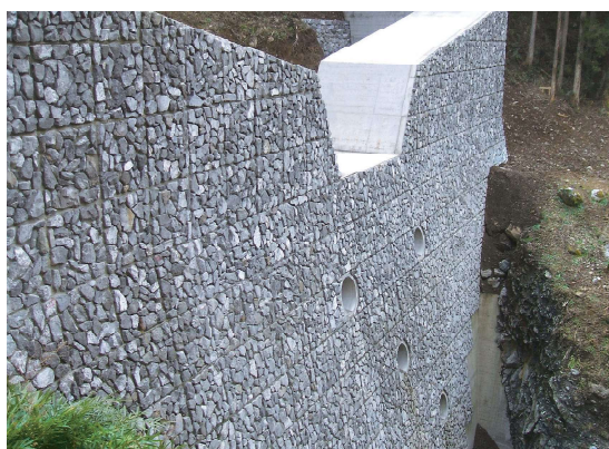
高知県 虎杖川 (砂防堰堤)
