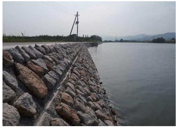
国土交通省 東詰護岸災害復旧（徳島県）
