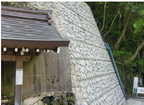
滋賀県 高野久居瀬線法面改良工事(永源寺)
