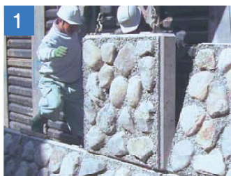
1 クレーンで製品を据付けます。
