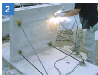
2 背面の長ボルトに鉄筋を溶接します。
