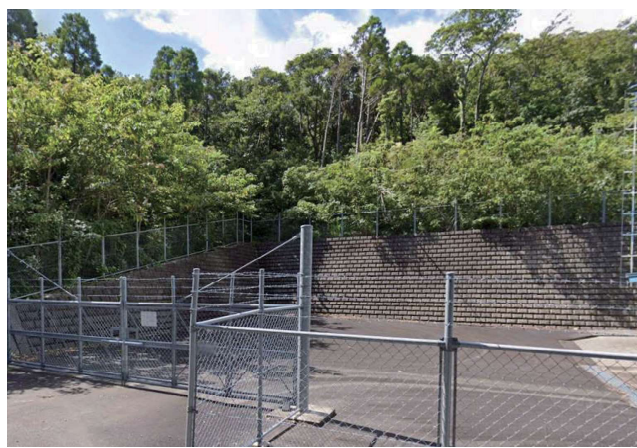
鹿児島県 一ノ谷発電所 施工後7年
