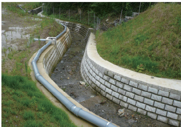
兵庫県 R477号災害復旧
