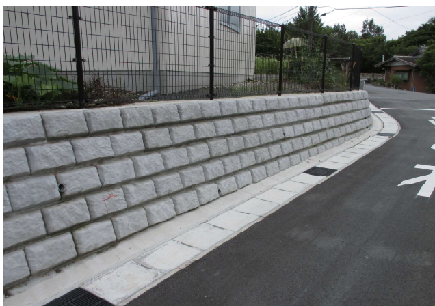
三重県 大紀町 町道注連小路線道路改良工事
