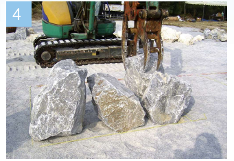
4 墨だし位置を参考に外周に石材を設置します。
