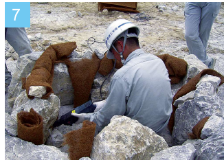
7 石材に削孔します。
