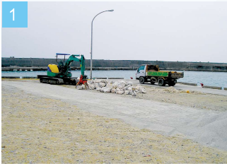
1 敷砂で製作ヤードを整地します。
