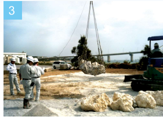
3 石材質量と凹凸を見ながら、所定の石材を選別します。
