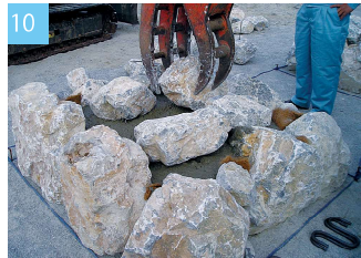
10 天端石を植石し養生。その後、間詰材を撤去します。
