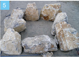
5 外周石 8 個設置状況。
