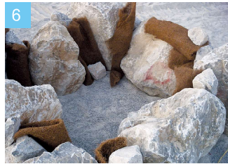
6 石材間に、間詰用割栗石とシートを用いて養生を実施します。
