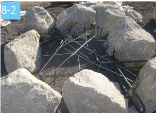
8-2 連結筋が必要な場合、アンカー部材と同時にセッティングします。
