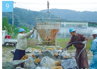
9 所定の容量の生コンクリートを投入し、打設します。
