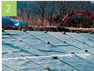
2 吸出し防止材または遮水シート敷設
