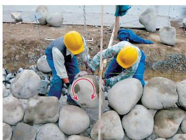
専用吊具使用・製品据付
